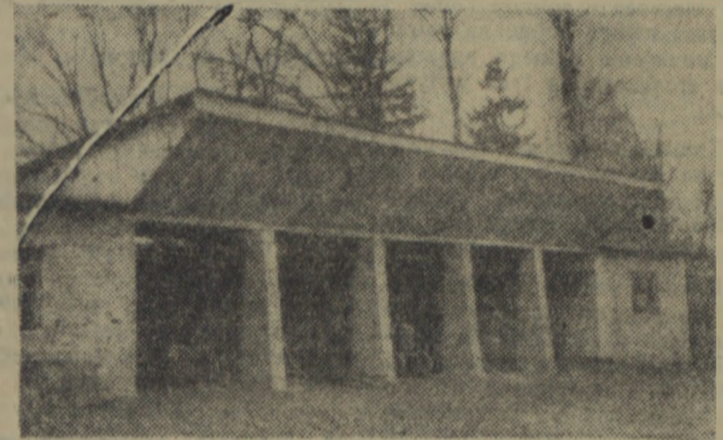
A to budynek gospodarczy wybudowany w PGR Skibno (zespół Bonin). Jest to typowa budowla PGR-owska, a zarazem typowy przykład bezymsności konstruktorów. Projektując wzniesiony strzelasty dach nie wzięli oni widocznego pod uwagę, że na wsi wieją czasami wiatry. W stosunkowo krótkim czasie dach tego budynku kilkakrotnie został zerwany przez silne wiatry. Nie pomagają żadne zabezpieczenia. A ile tu desek zamarnowano niepotrzebnie? Poza tym ani to ładne ani przydatne.
