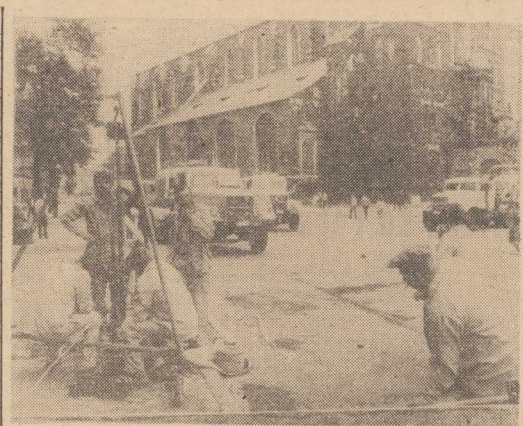
PRZEZ MIESIĄC ekipa węgierskich specjalistów naprawiać będzie kanały starego Krakowa. Węgrzy dzięki wymyślenie przez siebie metody uszczelniania kanałów zwaną „Superaquą”...
