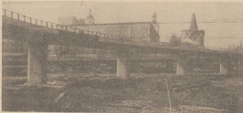
ESTAKADY na Podzamczu. Ażurowe betonowe konstrukcje...
