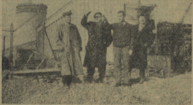
ŁODZCY posłowie na Sejm — Eugeniusz Ajnenkiel i Czesław Szczepaniak chcą dokładniej zaznajomić się z postępowaniem robot na ważniejszych budowach w mieście oraz warunkami pracy robotników zwiedził ostatnio Teatr Narodowy w budowie, halę sportową oraz teren budowy elektrociepłowni. Na zdjęciu: posłowie Ajnenkiel (drugi z lewej) i Szczepaniak (pierwszy z prawej) na terenie budowy elektrociepłowni. (CAF, fot. Scharfharer)
