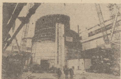
PLAC budowy drugiego 1000-megawatowego bloku energetycznego Południowoukraińskiej Elektrowni Atomowej. Powstaje ona w pobliżu systemu zapór, które spiętrzą wodę na Bohu (Bugu pld.) i pozwolą nawodnić ok. 100 tys. hektarów nieużytków. CAF — TASS
