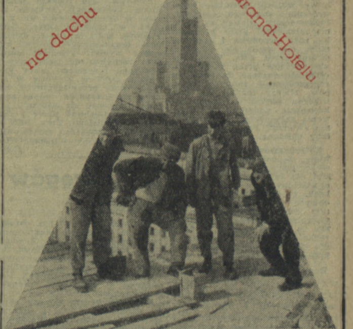
Na dachu: prace na dachu - lądowisku „Grand Hotelu” w Warszawie.
