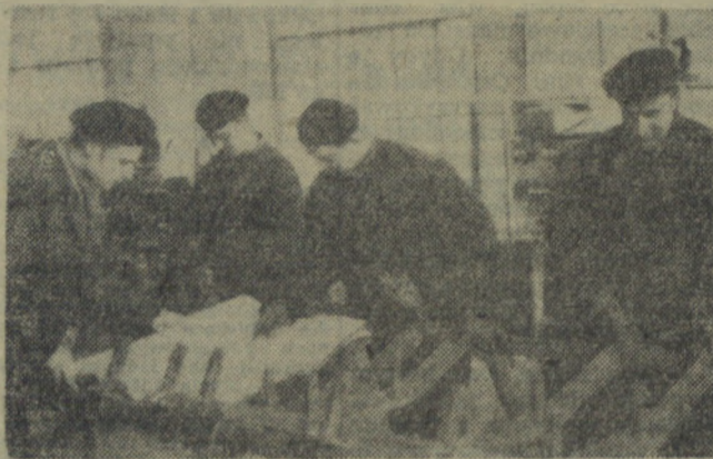
Jeden z trzech zamówionych transporterów taśmowych do klinkieru w cementowniach.
