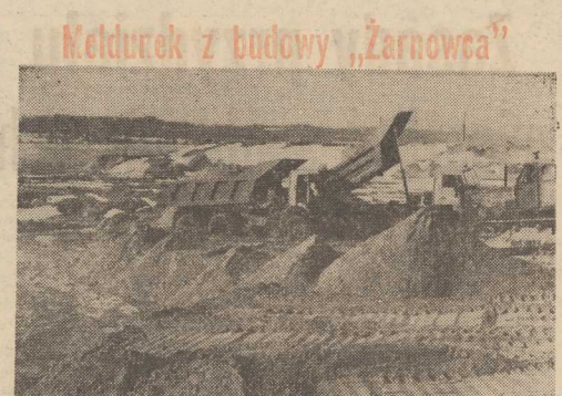
W TYM ROKU prace związane z budową elektrowni jądrowej „Zarnowca” (woj. gdańskie) będą się koncentrować na makroinwestycji terenu, budowie oczyszczalni ścieków, bocznic kolejowej oraz uruchomieniu budynków zaplecza administracyjno-technicznego. Tegoroczny plan robot budowlanych przewiduje także przebudowę dróg publicznych, wzniesienie budynku ośrodka badań środowiska i obiektu hotelo-mieszkalniowego, natomiast przyszły rok będzie początkiem robót przygotowawczych pod budynek główny elektrowni. Obecnie pracuje 45 przedsiębiorstw, a generalnym wykonawcą jest „Energobud” Warszawa. NA ZDJĘCIU: układanie rurociągów drenarskich na terenie budowy elektrowni jądrowej „Zarnowca” (CAF — Ukłejewski)
