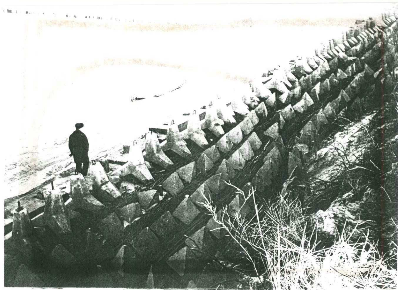
Na fot. : gwiazdobluki i ostrogi betonowe ochraniają wydmy brzegowe w Dziwnowie. Nad brzegiem p. Marian Oses, kierownik Obwodu Ochrony Wybrzeża w Międzyzdrojach (17 stycznia 1984 rok).
