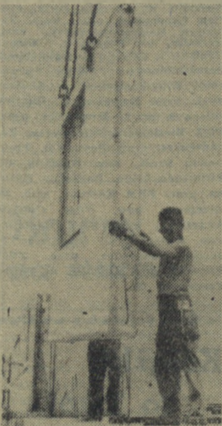
Montaż płyty ściiennej z otworami okiennymi.
