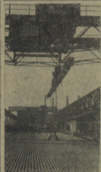
Znacznie lepiej niż w miesiącu ubiegłym pracują obecnie walcownicy. Wszystko wskazuje na to, że październikowy plan produkcji wyrobów walcowanych będzie przez huty podległe CZPH nie tylko wykonany, ale i przekroczony. Najlepsze wyniki wśród załóg walcowniczych uzyskują dotychczas walcownicy huty „Koseluzko”. Na zdjęciu: fragment huty „Koseluzko”. Na pierwszym planie składowisko wyrobów walcowanych (w tym wypadku są to szyny kolejowe). CAF — fot. Seko — Kondracki
