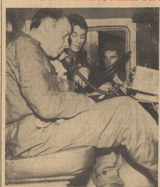
NA NASZYM ZDJECIU pracownicy brzołady remontowej łączą się z bazą. Fot. ST. CIEŚLAK
