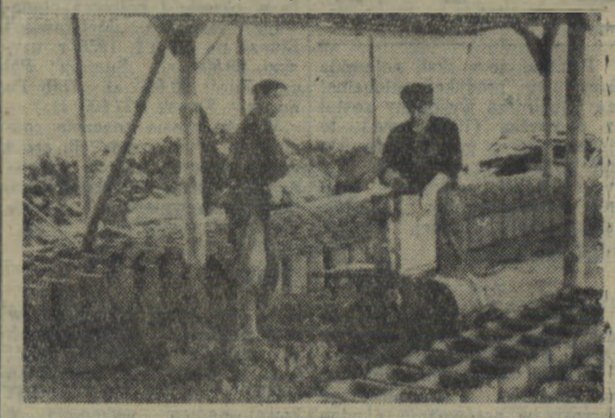
Robotnicy pracujący przy obsłudze elektrycznego wibratora.
