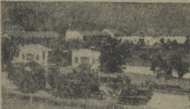
Stacja maszynowo-tractorowa w Sliven, w Bułgarii.
