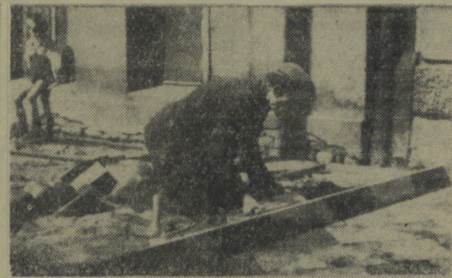
Płytki chodnika zakłada starszy już wiekiem Bartłomiej Tęcza. Na zdjęciu widzimy go przy pracy. (Tekst i zdjęcia W. Grabowski)
