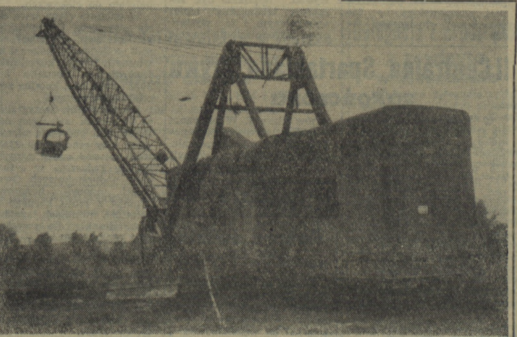
W JAWORZNIE prowadzone są prace przy budowie nowej kopalni odkrywkowej „Marian”. Pokłady węgla dobrej jakości znajdują się na głębokości od 3 do 5 metrów. Kopalnia da pierwszy węgla już w sierpniu br. Na zdjęciu: potężna 190-tonowa koparka na budowie kopalni. CAF — fot. Link
