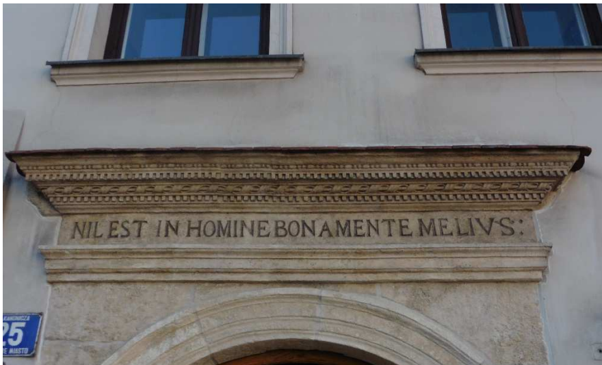
11. Kraków, Dom Długosza, portal prawdopodobnie z połowy XVI w.
