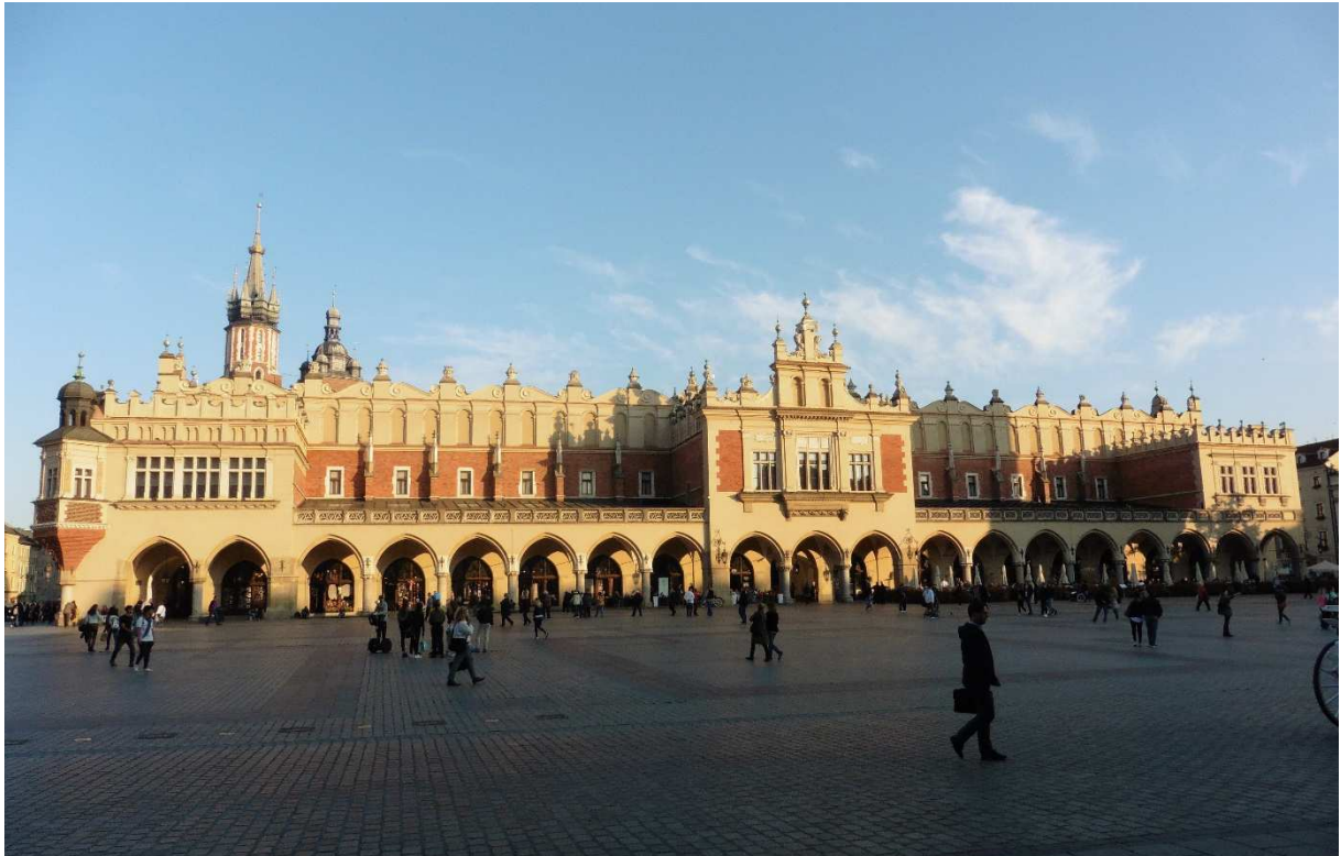
1. Kraków, Sukiennice (1556) przebudowa renesansowa, arch. Jan Maria Padovano?
