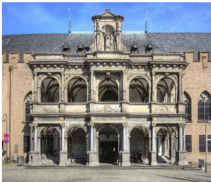
10. Kolonia, renesansowa loggia (1569) przy gotyckim ratuszu, arch. Wilhelm Vernukken
