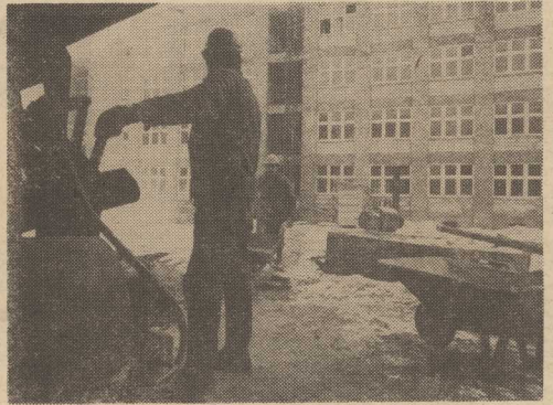
Praca na budowie przy ul. Broniewskiego.
