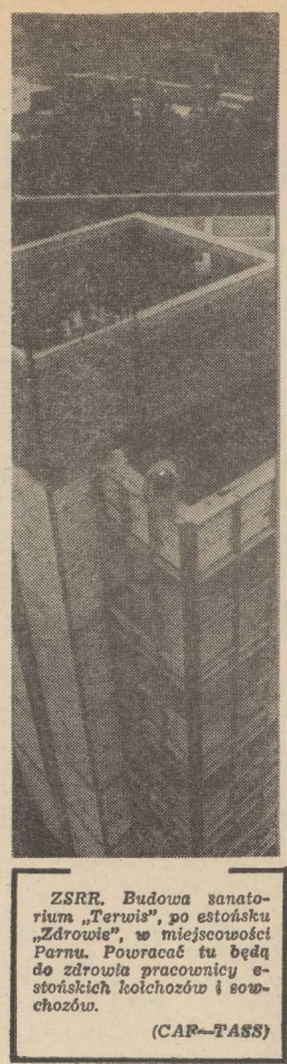
ZSR. Budowa sanato- rium „Terwis”, po estońsku „Zdrowie”, w miejscowości Parnu. Powracać tu będą do zdrowia pracownicy estońskich kochiwozów i so- choch.
