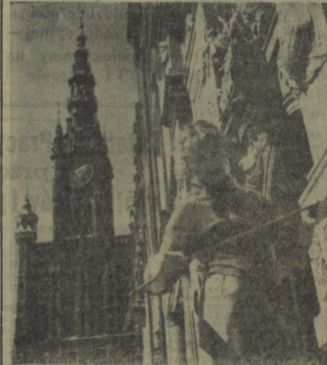
Czestymi gośćmi na rusztowaniach otaczających odbudowywane kamieniczki Starego Miasta w Gdańsku są studenci Wydziału Architektury Politechniki Gdańskiej. Przeprowadzają oni inwentaryzacje zabytków, przenosząc na papier fragmenty zabytkowej architektury.
