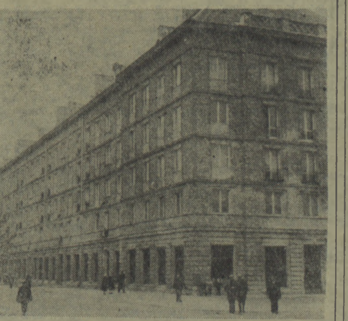
W Szczecinie powstaje Śródmiejska Dzielnica Mieszkanlowa. Pierwsze bloki oddane zostały do użytku ludności. Na zdjęciu: fragment nowej dzielnicy Szczecina. CAF — fot. Kondracki
