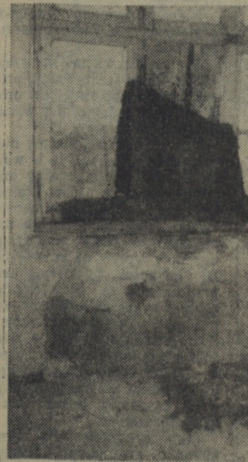
W taki sposób zabezpieczane są okna niektórych mieszkań robotników PGR Biała.
