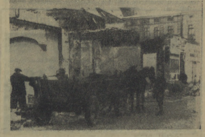
Fragment odcinka domów, które ulegają rozbiórce. Fot.: W. Kaczyński
