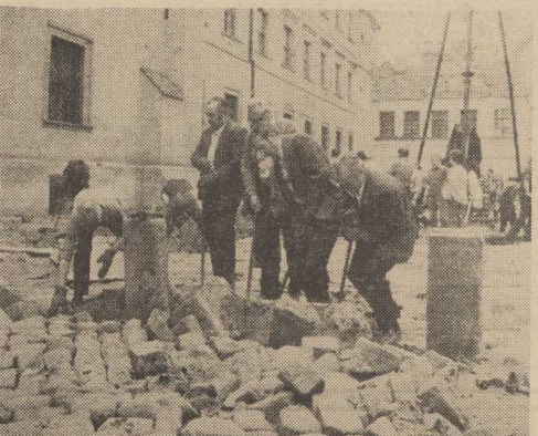
NA ZAMKU Książki Pomorskich Czyn Partyjny wykonywali pracownicy szczecińskich instytucji kulturalnych i dziennikarzy. Betonowano ławy fundamentowe, kopano rowy pod kable, prowadzono prace porządkowe. Jak uidać na zdjęciu łatwo nie było.
