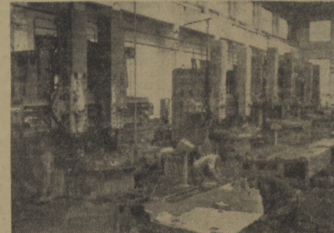
Raciborska Fabryka Wyrobów Metalowych. Na zdjęciu: fragment hali montażowej. Na pierwszym planie szpachlowanie części obrabiarek. W głębi częściowo zmontowane obrabiarki.
