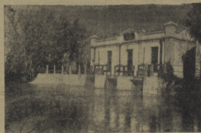
Wraz z budową dużych elektrowni wodnych prowadzi się w Związku Radzieckim na szeroka skalę budowę kolchozowych elektrowni wodnych na małych rzekach. Na zdjęciu: elektrownia wodna w kolchozie im. Stalina (Uzbecka SRU).
