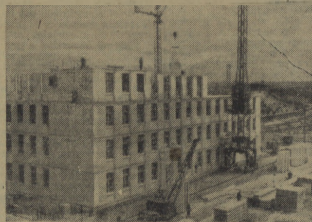
W ciągu najbliższych lat Moskwa otrzyma około 300 nowych szkół. Na zdjęciu: budowa szkoły z płyt prefabrykowanych przy Szosie Chorożewskiej w Moskwie.
