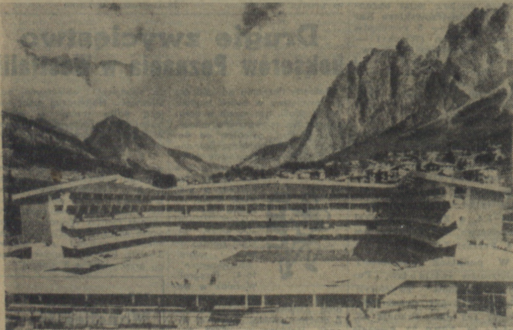
Na zdjęciu: budowa nowego stadionu zimowego w Cortina d'Ampezzo, na którym odbędą się zimowe igrzyska.
