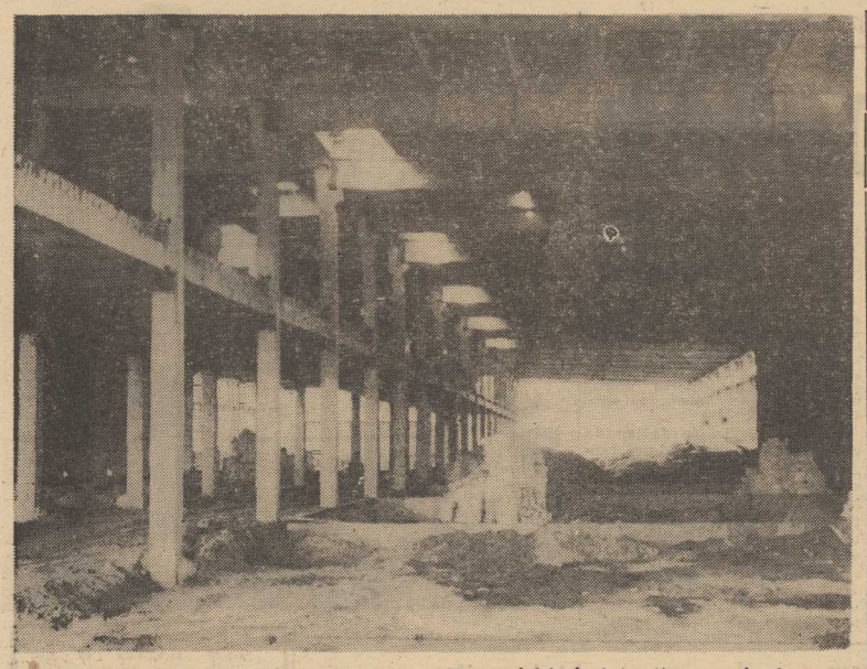
OTO przepasna hala głównego magazynu. Tu pomieści się 4 tys. ton owoców i warzyw. Połowa w komorach chłodzonych. (Fot. — A. Wituszyński)
