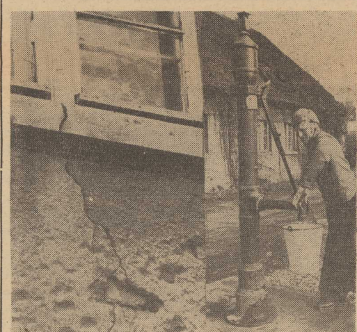
POD kolumnami wielkich „Berlietów” drży ziemia i rysują się ściany budynków. Foto: Z. Jodkowski
