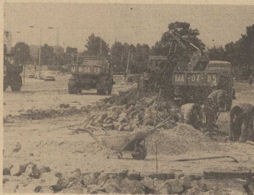
DOBIEGA końca przebudowa ul. Jana z Kolna.
