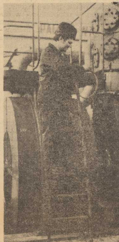
CZESŁAW MARCINIAK z Wytwórni Gazów Technicznych w Koszalinie obsługuje skonstruowaną w NRD sprężarkę powietrza do produkcji tlenu. (CAF — Staszyszyn)
