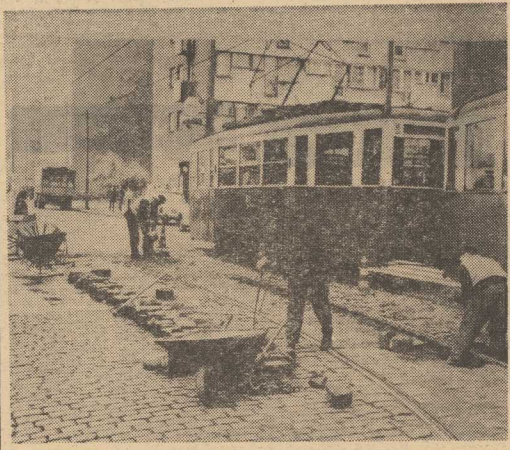
KORZYSTAJĄC ZE SPRZYJAJĄCEJ AURY pracownicy Miejskiego Przedsiębiorstwa Komunikacyjnego dokonują ostatnich w tym roku remontów torowisk tramwajowych na ulicach śródmieścia. Może dzięki tym pracom tramwaje będą mniej „rzuć” i jazda odbywać się będzie w bardziej komfortowych warunkach. NA ZDJĘCIU: remont torów na ul. Obrońców Stalingradu.
