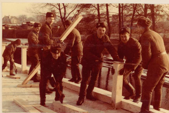
Żołnierze w trakcie budowy mostu.
