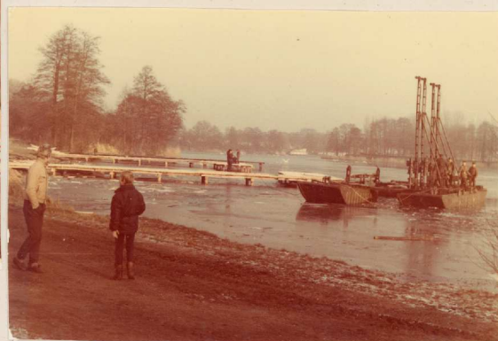
Urządzenia kafarowe przy budowie pomostów.
