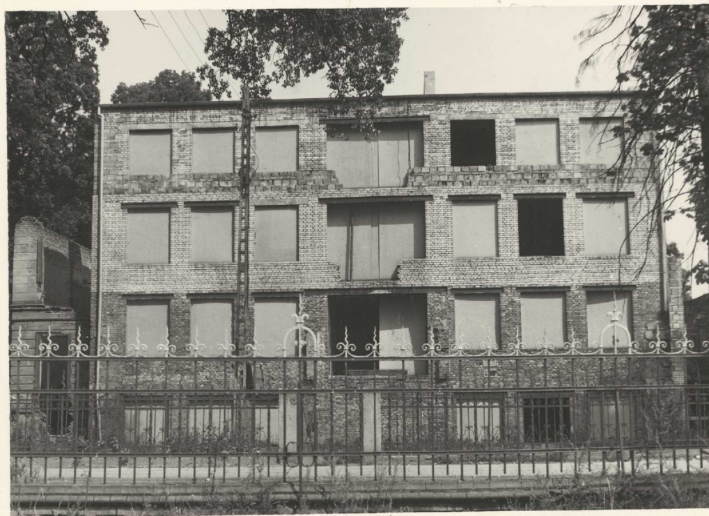
ADAPTACJA BUDYNKU NA NOWĄ PRZYCHODNIĘ.
