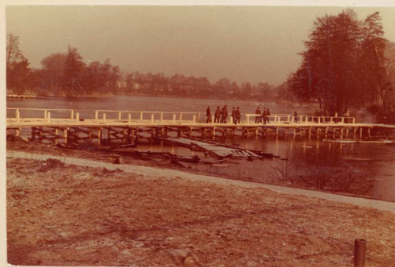
Widok na budowany most.
