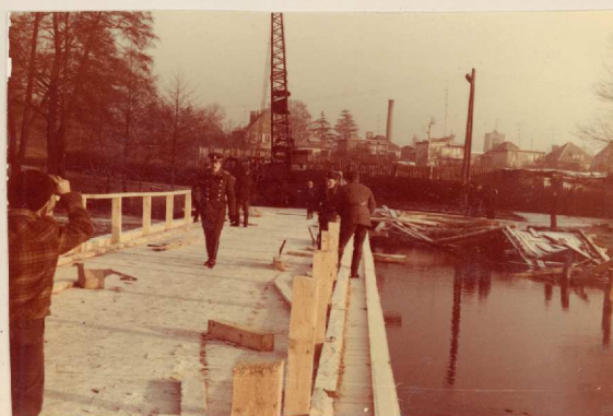
Prace końcowe przy budowie mostu.
