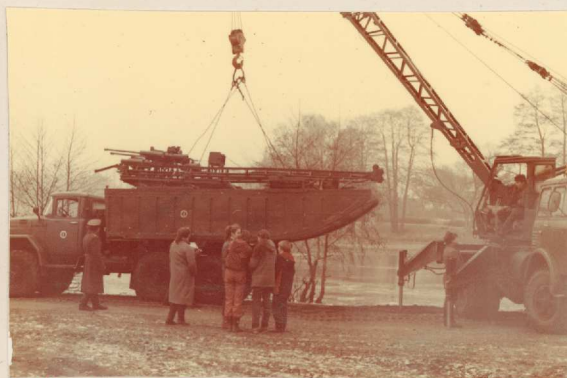
Montaż kafaryjnego urządzenia baterijnego.
