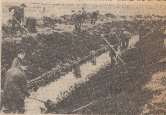
Żołnierze układają darninę wzdłuż wykonanego już rowu melioracyjnego w Oborzanach.
