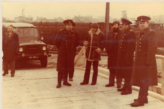
Po próbie odbioru mostu.
