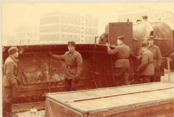
Rozładunek i montaż pontonów.
