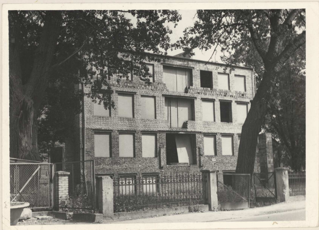
PRZYCHODNIA REJONOWA W BUDOWIE
