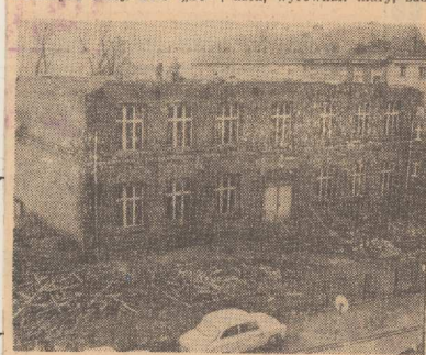
Na zdjęciu: tak wygląda obecnie budynek częściowo spalonej Szkoły Podstawowej nr 2. Pracownicy PBRol z Dębna usuwają resztki zniszczonego dachu.
