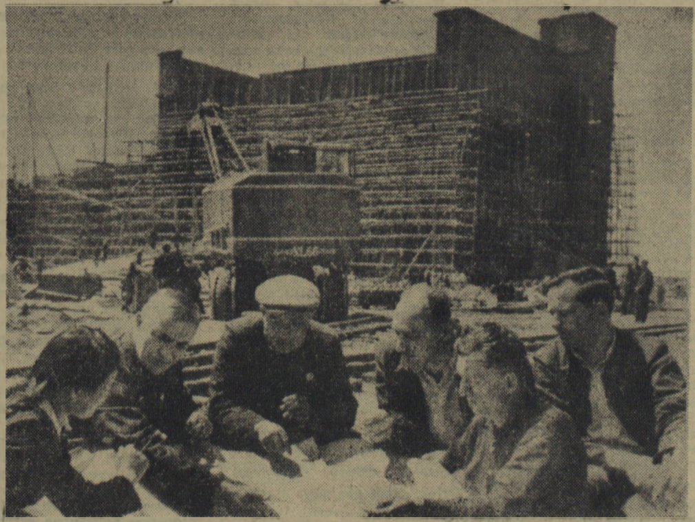
Szybko postępują prace przy budowie Państwowej Cukrowni w Klamucie (prowincja Heilongkiang w Chinach), budowanej przy pomocy fachowców polskich. Przewiduje się, że zakończenie budowy i instalacji urządzeń polskiej produkcji nastąpi w końcu br. Cukrownia będzie produkowała kilkadziesiąt tysięcy ton cukru rocznie.
