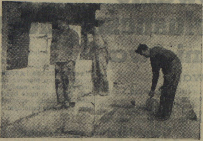
Pracująca przy budowie domu mieszkalnego na „Starówce“ brygada Bolesława Kublika systematycznie wykonuje swą normę w 100 proc. Na zdjęciu: brygada przy pracy.
