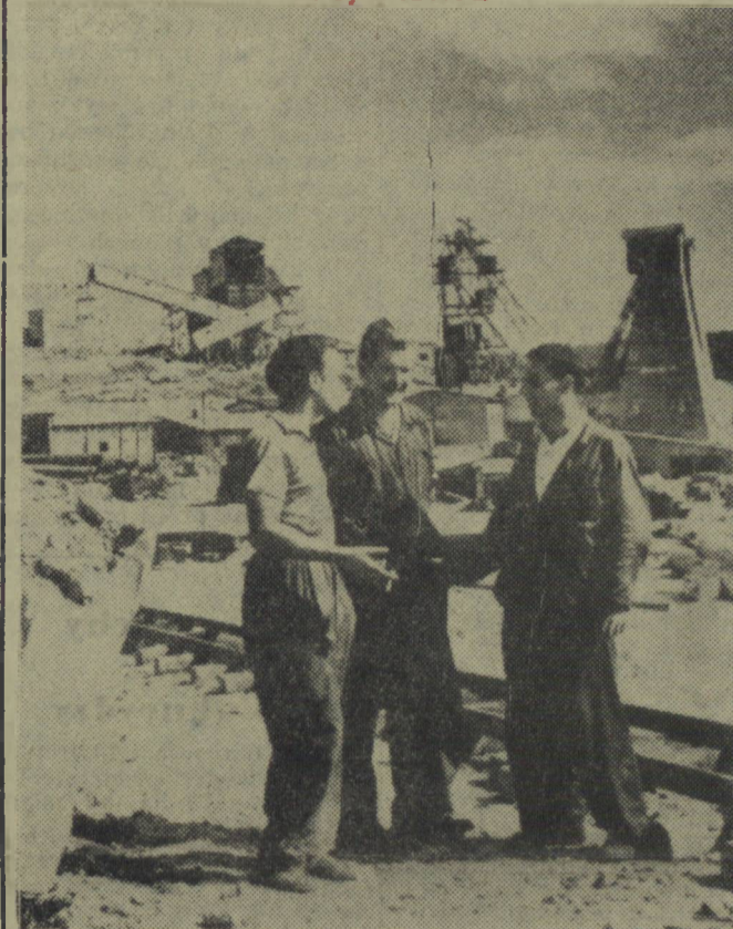
Na zdjęciu: na budowie zapory wodnej w Lipnie — Czechosłowacja, (obwód Budziejowice).
