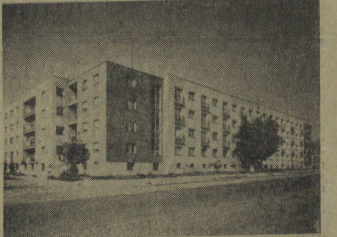
W nowych Węgrzech buduje się słoneczne i nowoczesne mieszkania. W roku 1954 wybudowano o 65 proc. więcej niż w roku poprzednim.
