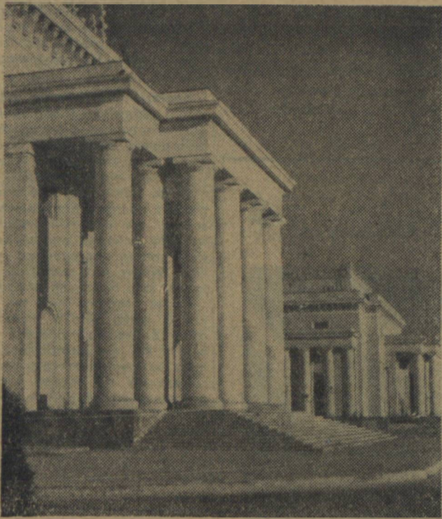
Na zdjęciu: fragment elewacji budynków skrzydłowych Pałacu.
