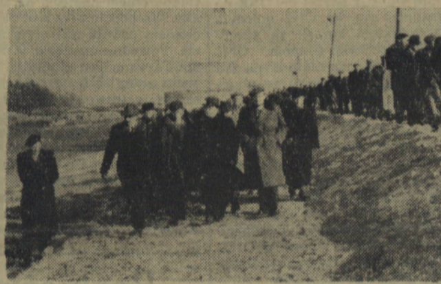
W dniu 27 stycznia br. w X-tą rocznicę wyzwolenia Śląska, budowniczy Goczalkowickiego Kompleksu Wodnego rozpoczęli próby spiętrzenia wody, którymi zakończono pierwszy etap budowy.
