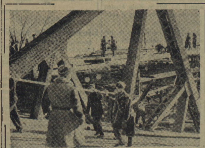
Na zdjęciu: odbudowa mostu kolejowego. Robotnikom polskim niesła braterską pomoc żołnierze Armii Radzieckiej. (Zdjęcie dokumentalne). (Fot-CAF)
