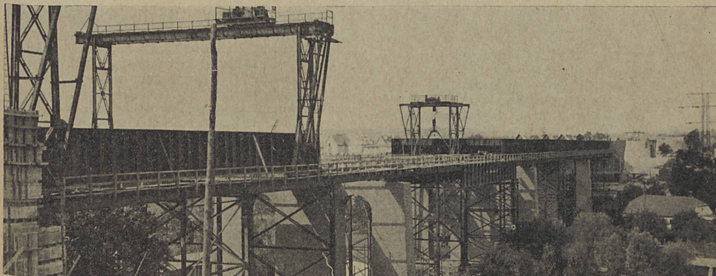
Talübergang der Reichsautobahn bei Rüdersdorf (Bauwerk 119d) 1600 to geschweißte Konstruktionen
