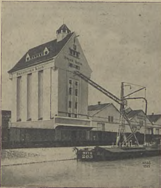
Silospeicher mit pneumatischer Förderanlage des Bayerischen Lloyd, Passau
