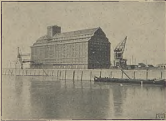
Silo der Budapester zollfreien Hafen-A.-G., Budapest
