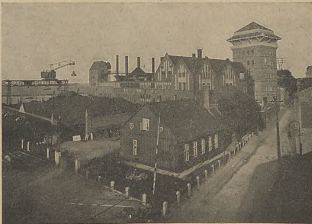
Dampfkraftwerk Stralsund der Ueberlandzentrale Pommern A.-G.
