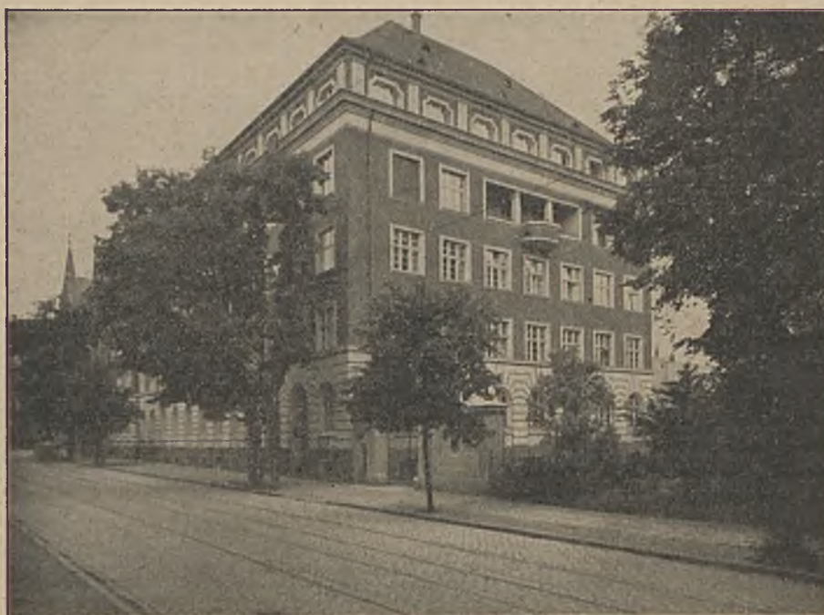
Hauptverwaltungsgebäude der Ueberlandzentrale Pommern A.-G., Stettin Birkenallee 5/7.
