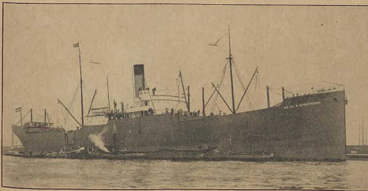
Dampfer „Heinz W. Kunstmann“ 8700 to. ladend, der Reederei W. Kunstmann, Stettin. Speziell gebaut für Erz- und Kohlenfahrten. Das Schiff hat eine Länge von 379 Fuß und eine Breite von 52 Fuß und indiziert eine Maschinenleistung von ca. 1900 PS.
