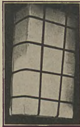
Abb. 3. Wie man heute Parfümerien exportiert: Statt der Kiste ein mehrfach umreifter Holzstoffkarton, der mit Jute verleimt wird.
