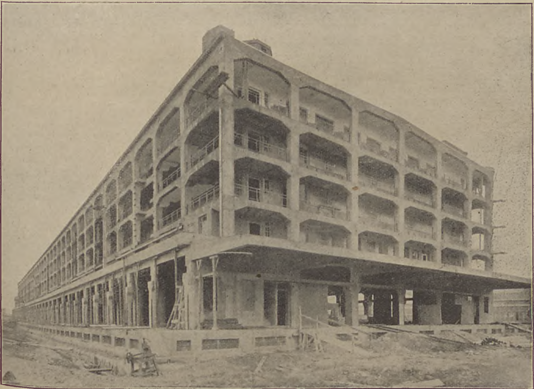
Abb. 3. Der neue Schuppenspeicher.
