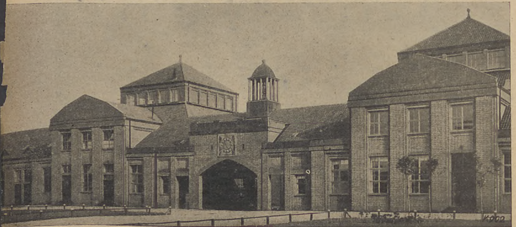
Schachtanlage (Gesandete Reichsmaßziegel).
