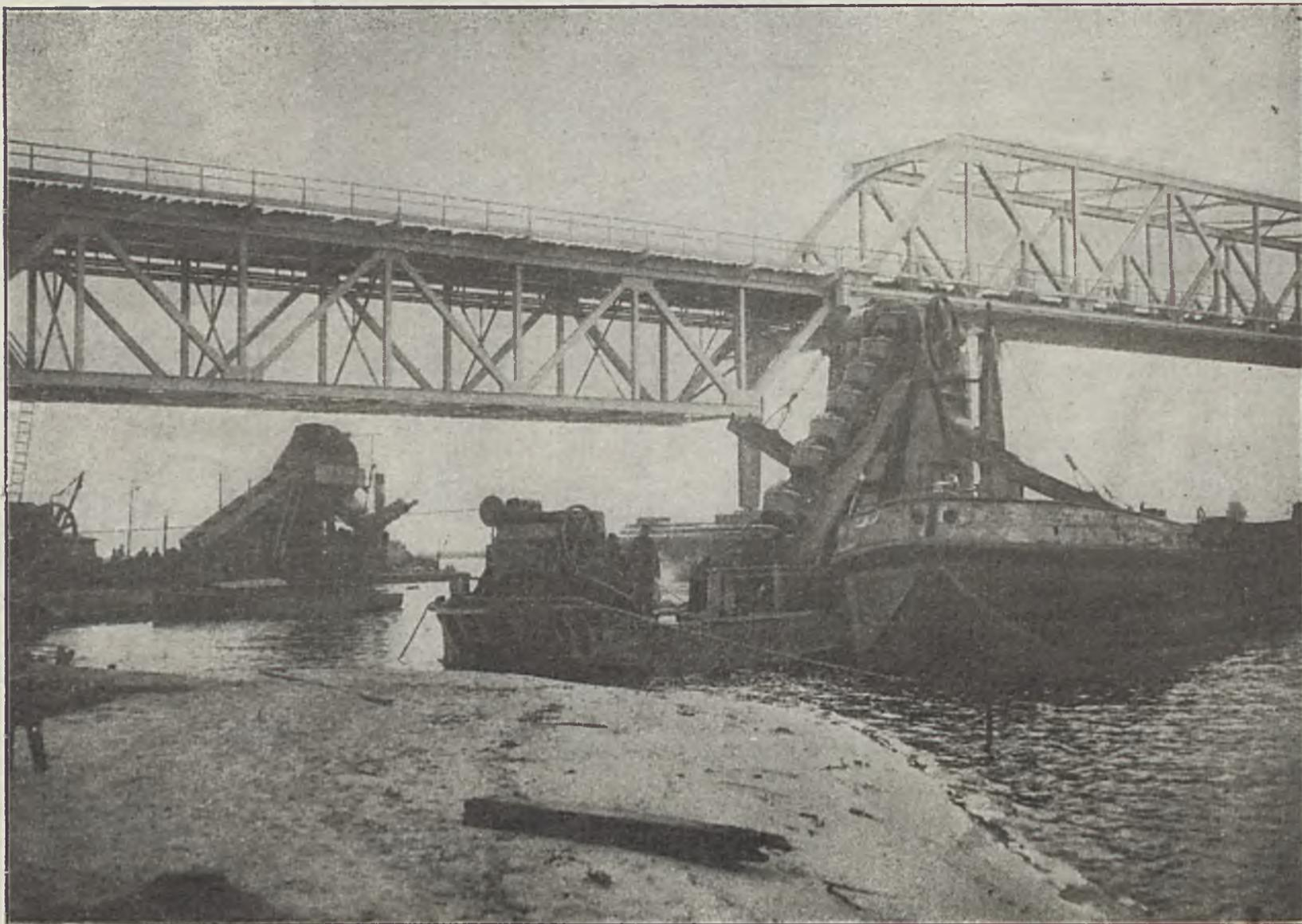
Baggerarbeiten an der neuen Eisenbahnbrücke der Güterumgehungsbahn über die Oder
