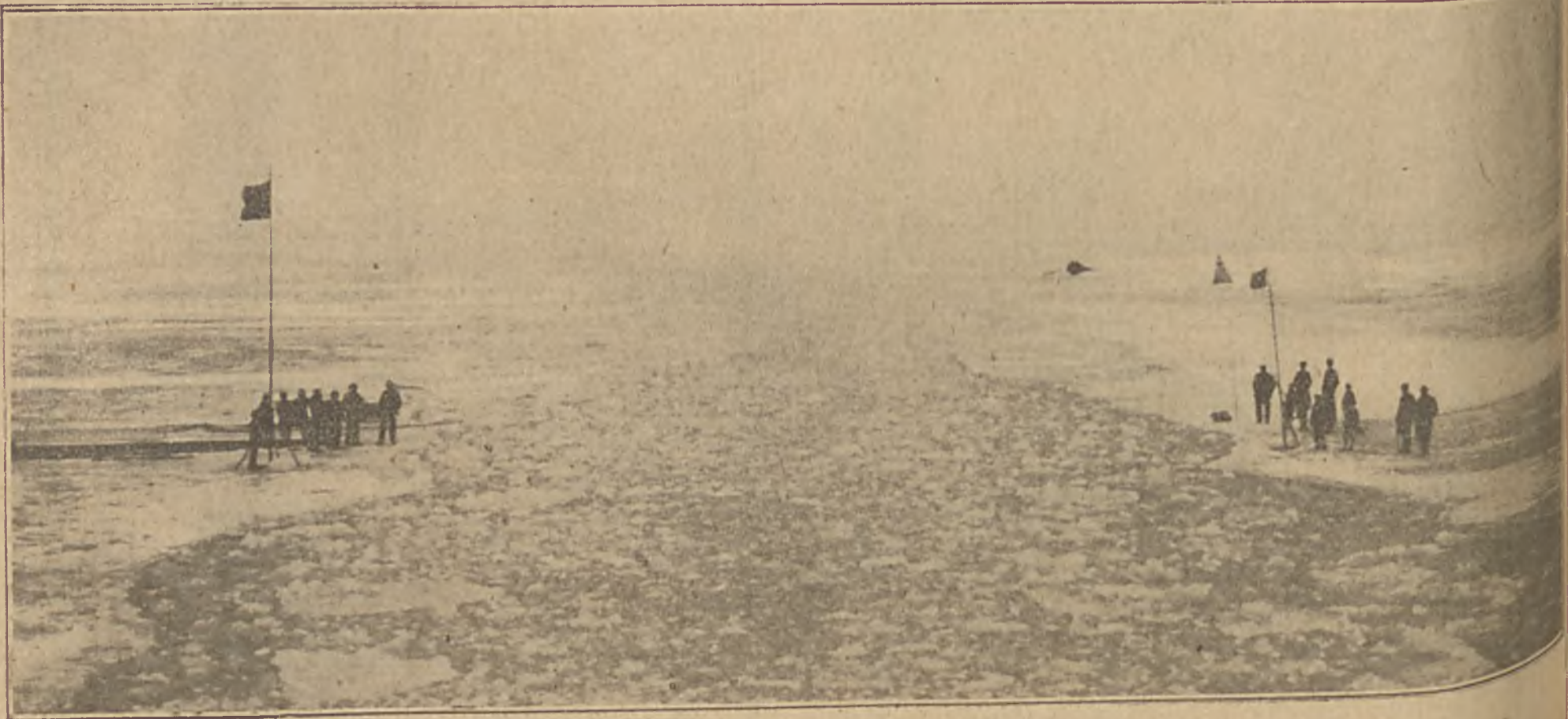
Uebergangsstelle „Eissteg“ im Stettiner Haft an der Eisbrecher-Rinne. Nach dem Passieren der Eisbrecher wird der „Eissteg“ aus Balken und Brettern über die Rinne geschoben und ermöglicht so einen Fußgänger- und Wagenverkehr über das Haft.
