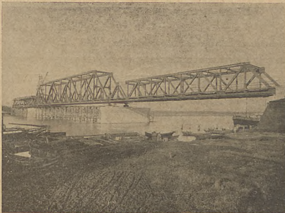
Montage der zweigleisigen Eisenbahnbrücke über die Ostoder bei Stettin. Gesamtlänge der Brücke 225 m
