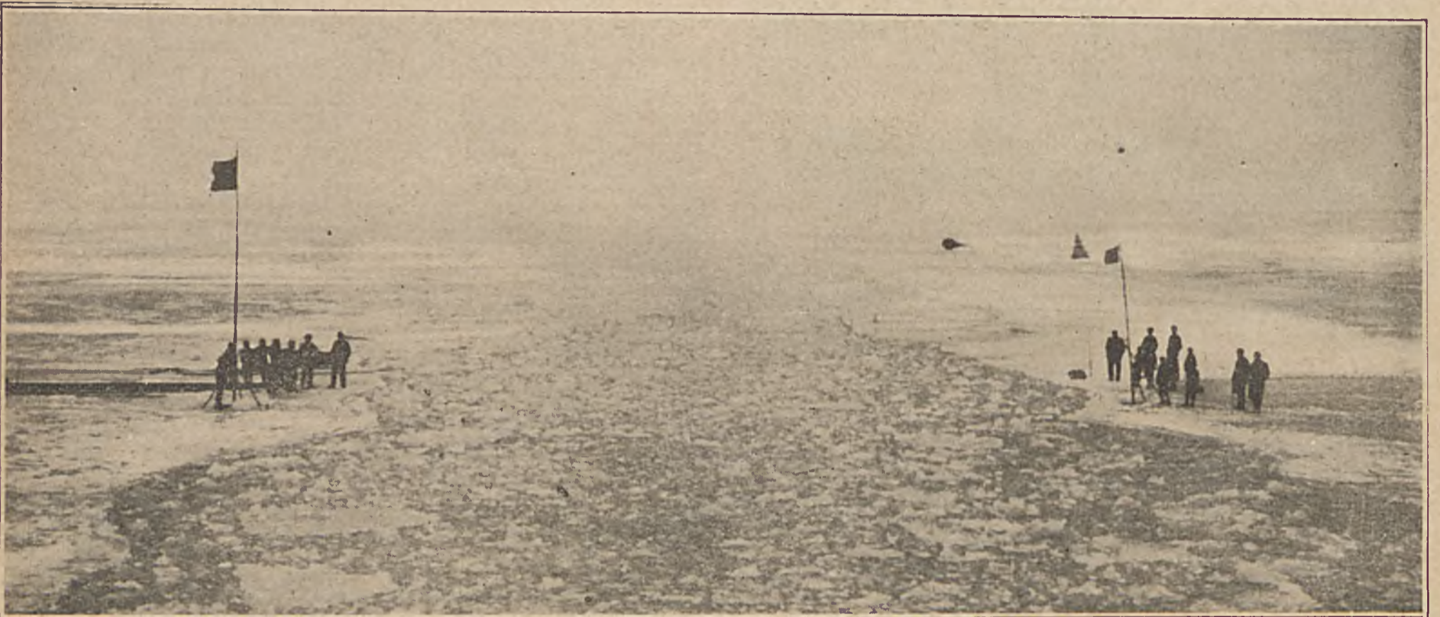
Uebergangsstelle „Eissteg“ im Stettiner Haff an der Eisbrecher-Rinne. Nach dem Passieren der Eisbrecher wird der „Eissteg“ aus Balken und Brettern über die Rinne geschoben und ermöglicht so einen Fußgänger- und Wagenverkehr über das Haff.
