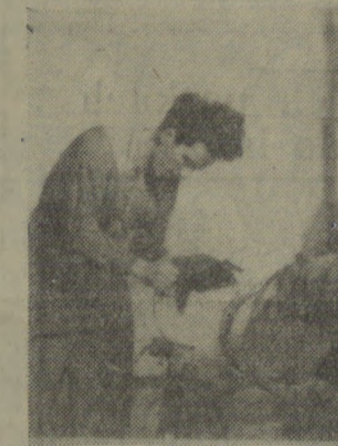
Półokrągła metalowa płyta — odlew z matrycy — gotowa! Za chwilę stereotypier Henryk Gawel (z lewej) będzie ją frezował. Dziełnie pomaga mu Stefan Żuk.
