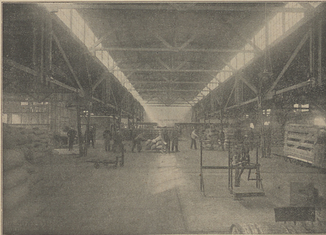
Bild 3: Der neue Kaischuppen IV.
